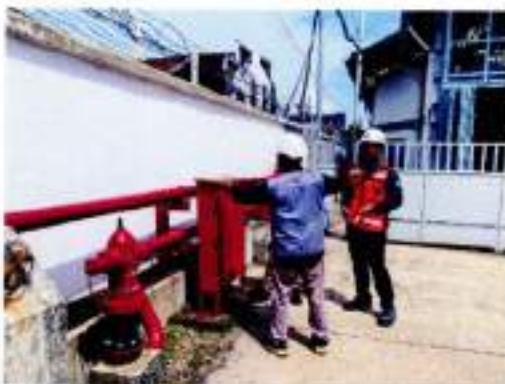
Pengecatan Box Hidrant Barat
