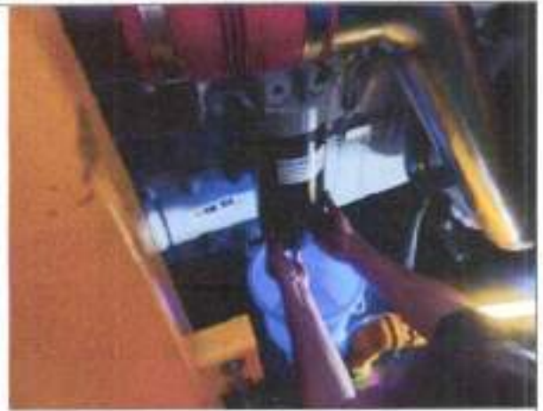
Pemasangan Filter Oli Genset CH10929
