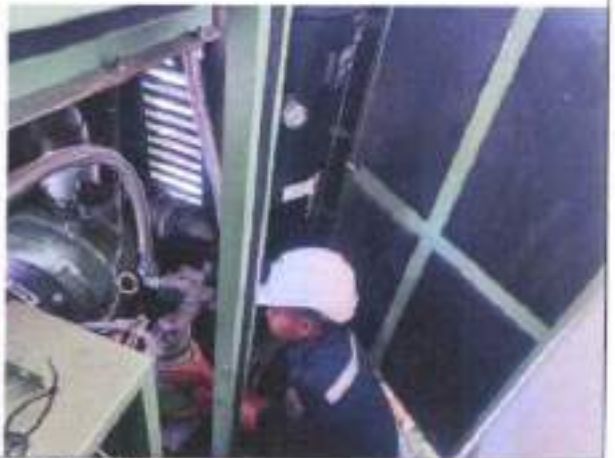
Pemasangan Filter Oli
