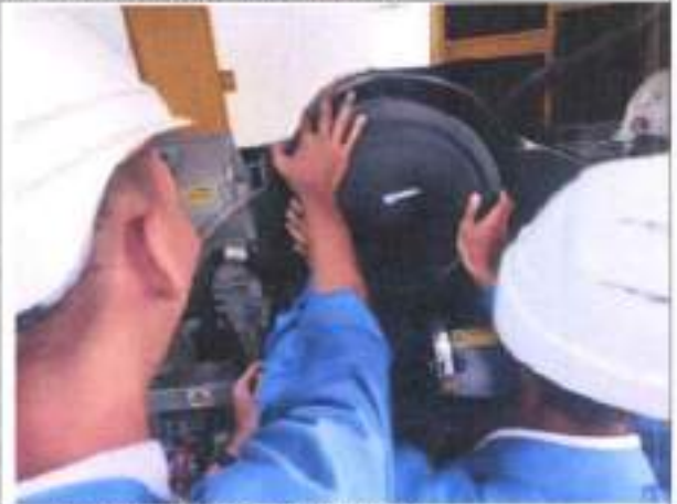
Pemasangan Filter Udara Genset PERKINS SEV551F/4
