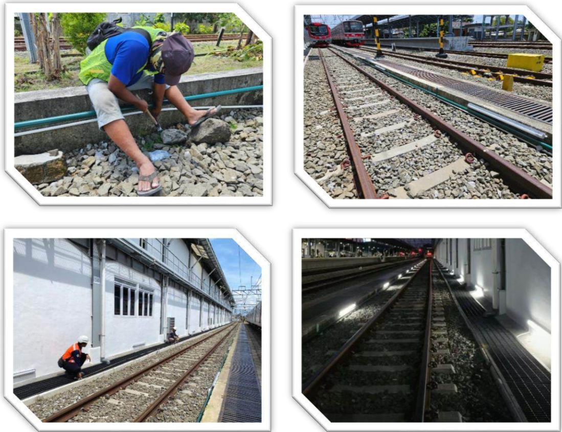
Gambar 2.15 Pemasangan Lampu Penerangan Perawatan Jalur 6
