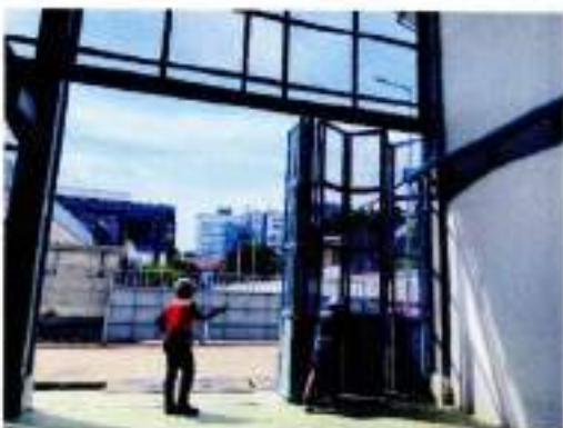
Pemeriksaan Pintu Sisi Utara
