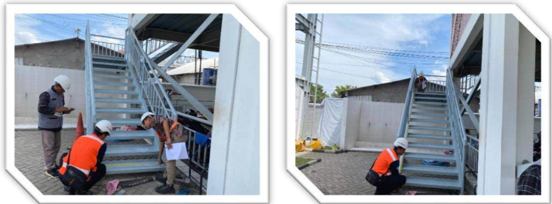
Gambar 2.19 Pengecatan Tangga Mushola
