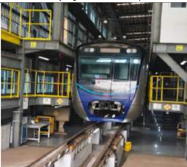
Loos light mentenance untuk daily check
