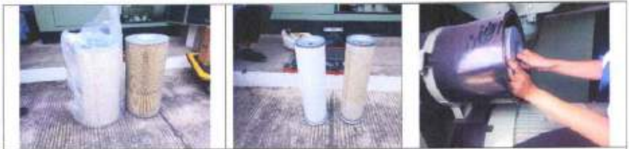
Pemasangan Filter Udara Internal dan External
