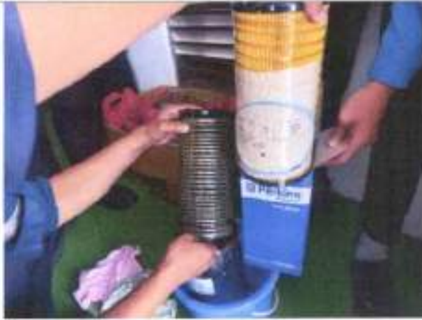
Pemasangan Filter Oli Genset CH10929
